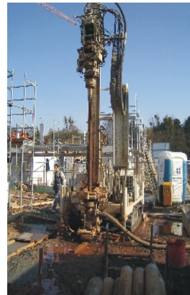
Bild 2: Bohrgerät für Erdwärmesonden
