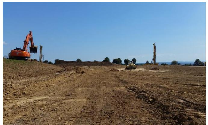
Bild 1: Impressionen von der Baustelle während der Erdarbeiten und Herstellung der Rüttelstopfsäulen
